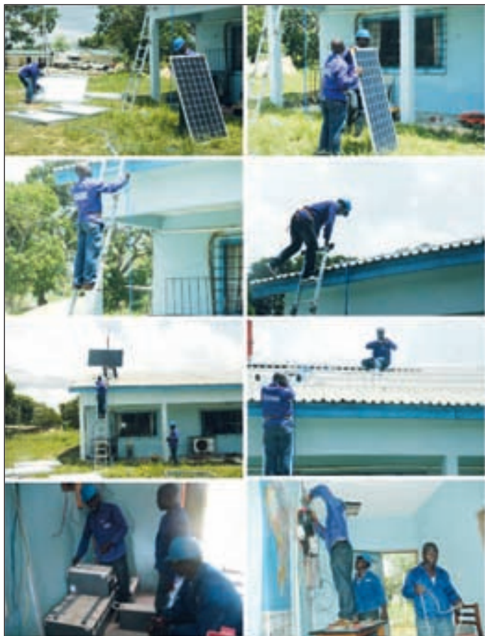
Aufbau & Installation der Solaranlage
